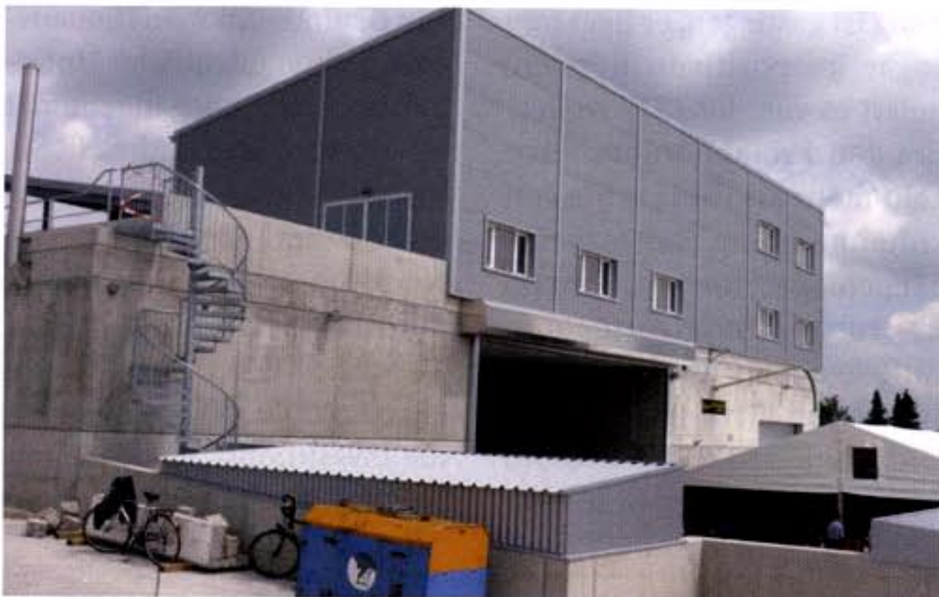
Als Neuinvestition hat die Lötscher Kies + Beton AG ein Kombigebäude mit Schlammpresse und Ausstellungsraum erstellt
